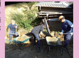
令和元年度房総半島台風被害の復旧支援
